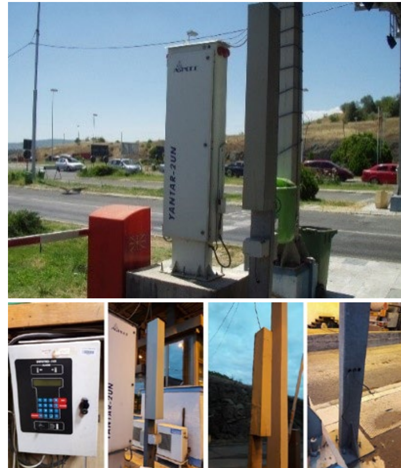
Опрема за детектирање на нелегално внесување и транзитирање на радиоактивни материјали.
